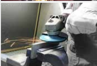
Preparación de cordones de soldadura
