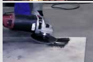
Eliminación de imperfecciones
